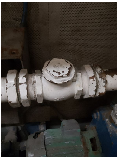
Clapet sur décharge lavabo DN 2"
