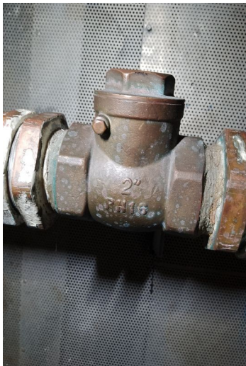
Clapet sur décharge lavabo DN 2"
