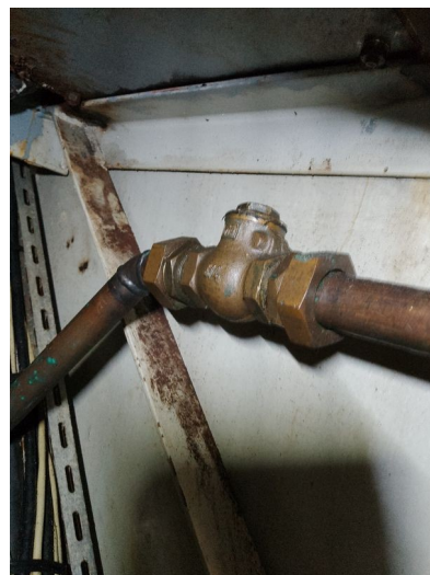
Clapet sur décharge pompe eaux usée DN 3/4 "
