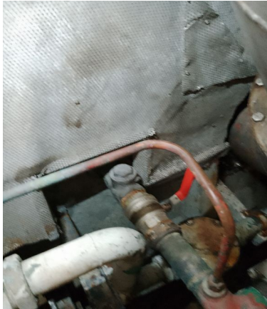
Clapet sur décharge pompe assèchement DN 2"
